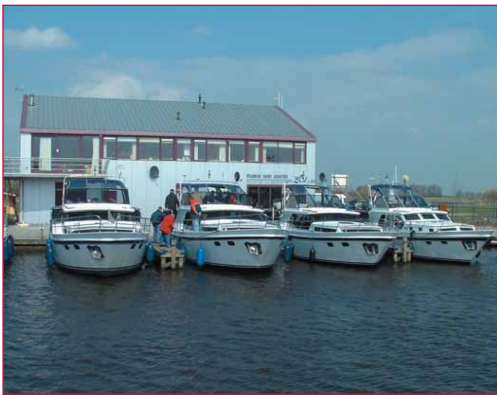
Das neue Gebäude im wassersportgebundenen Betriebspark „t Ges in Sneek“ beinhaltet den Empfangsraum, moderne Sanitäranlagen, eine Halle für zwei Schiffe und eine Wohnung in der ersten Etage.
