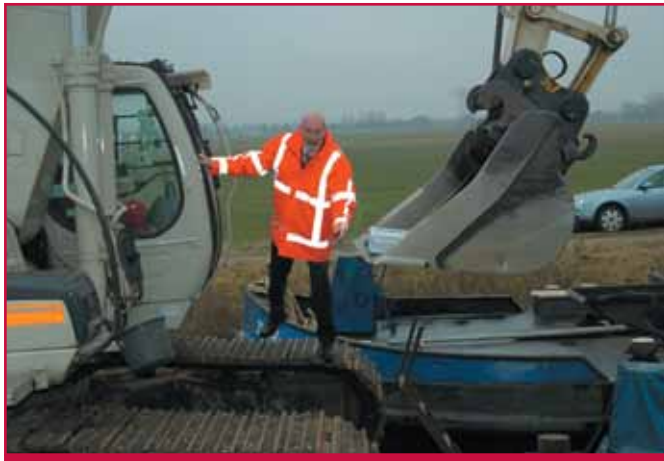
Geldübergabe mit dem Bagger.
