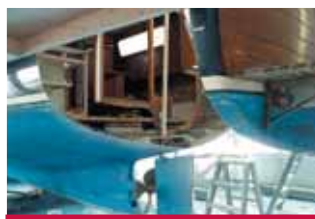
Der Rumpf wurde durchgesägt...
