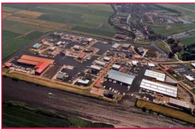
Diese Luftaufnahme zeigt die Größe des Gewerbegebiets.
