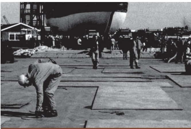
Das Gelände musste mit Stahlplatten ausgelegt werden.
