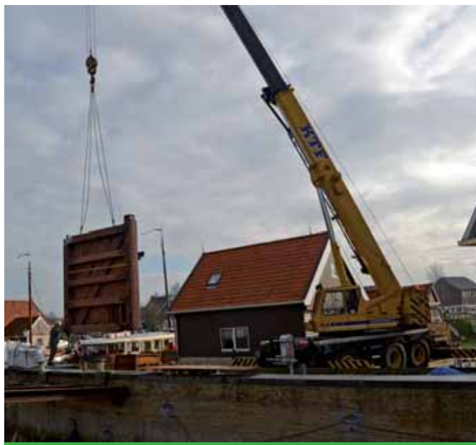
Ein Kran hievte die neuen Tore in die Schleusenkammer.
