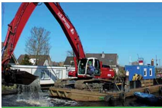
Baggerarbeiten in Reduzum und Akkrum Frühjahr 2015
