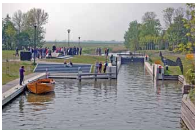
Neue Schleusen beim Dorf Alde Leie an der Elfstädteroute.
