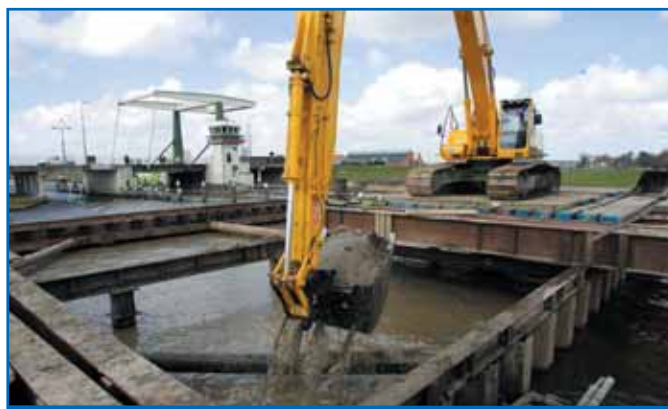
Baggerarbeiten im Jeltesloot.
