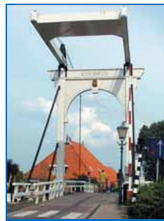
Die „Koebrug“ in Stavoren.
