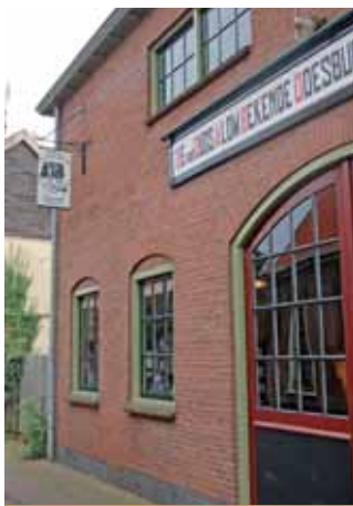
Das historische Gebäude der Senffabrik.
