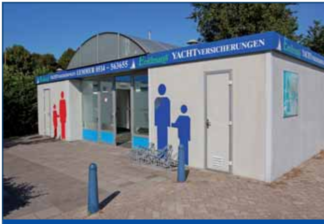
Viele Jachthäfen bieten moderne Sanitäranlagen.
