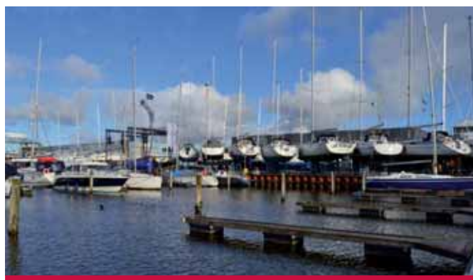
Blick in den Jachthafen mit 40 t Krananlage.
