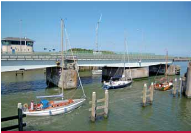
Die Lorentzschleuse soll verbreitert werden.
