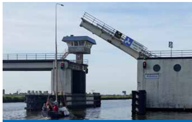
Die Brücke zwischen Jirnsom und Oude Schouw.
