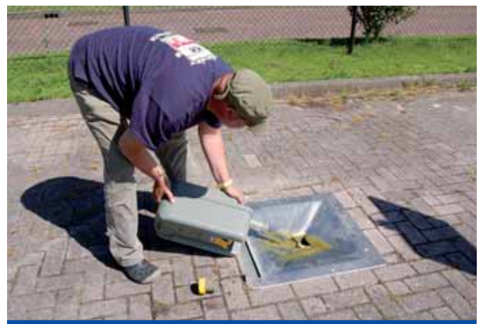
Unterirdische Fäkalienstation für Camper.
