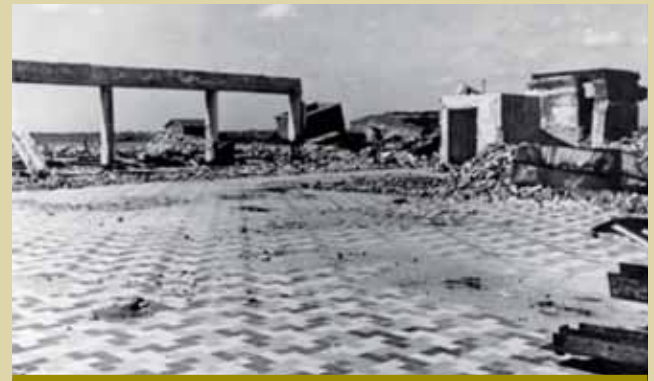
Boden der Schalterhalle nach einem Bombenangriff.
